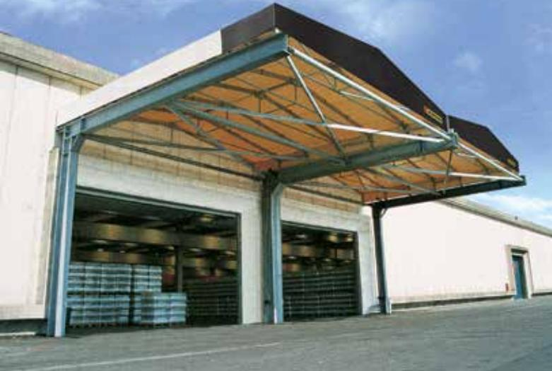
Struttura completamente a sbalzo.
